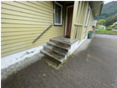
Trapp til overbygt inngangsparti 1.etg.
