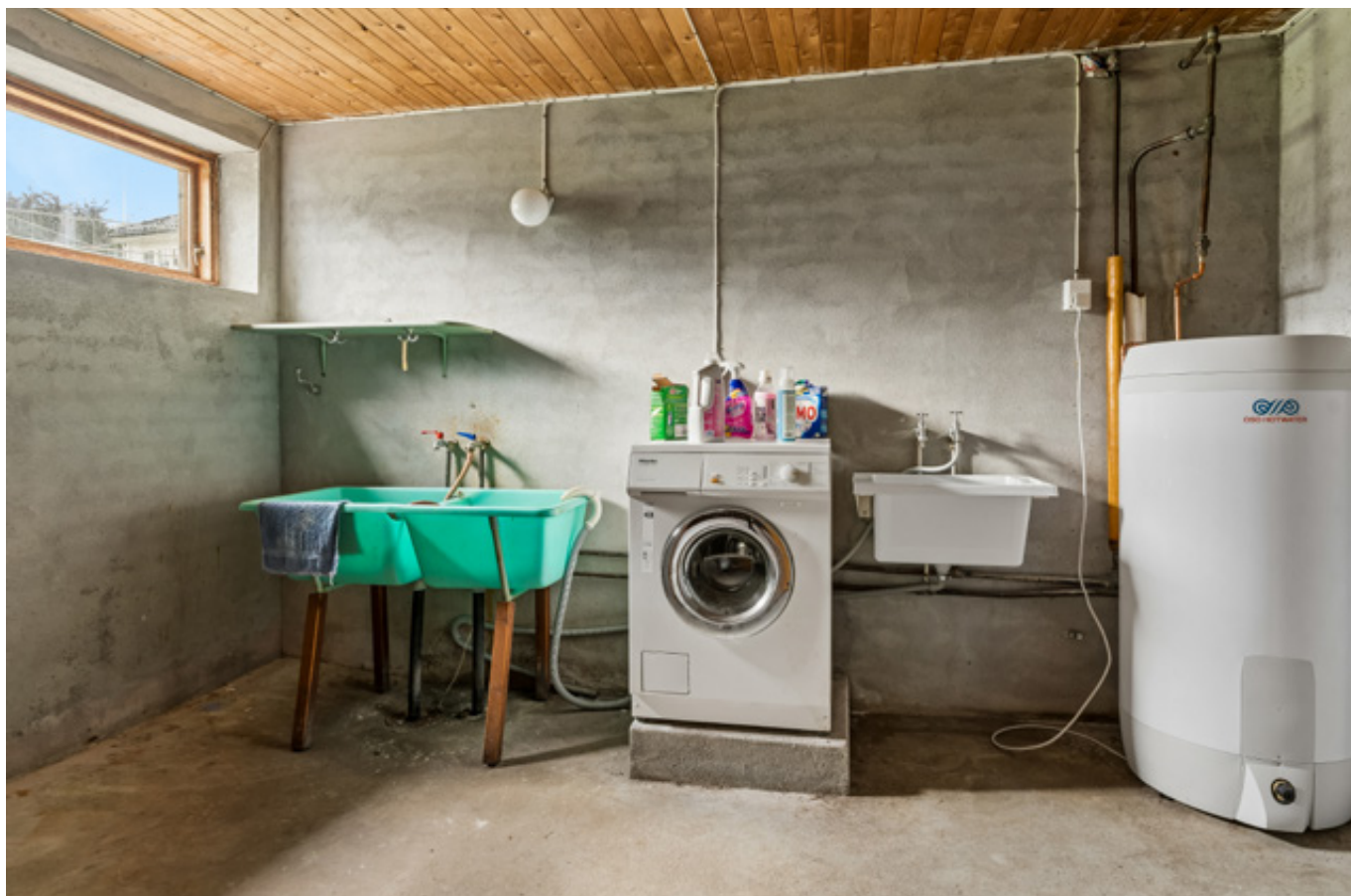
Vaskerom i kjellaren med varmtvatnstank frå 2021, opplegg for vaskemaskin og skyljekar.
